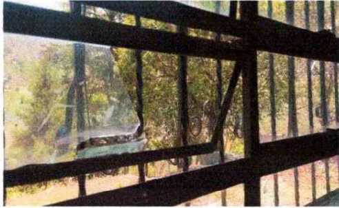
Foto 1: REPARACION DE VENTANALES
