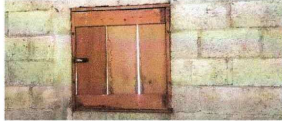
Foto 2: SUSTITUCION DE VENTANA
