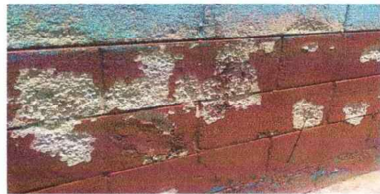
Foto 12: REPARACION DE PAREDES
