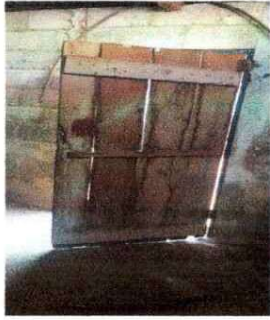
Foto1: SUSTITUCION DE PUERTA
