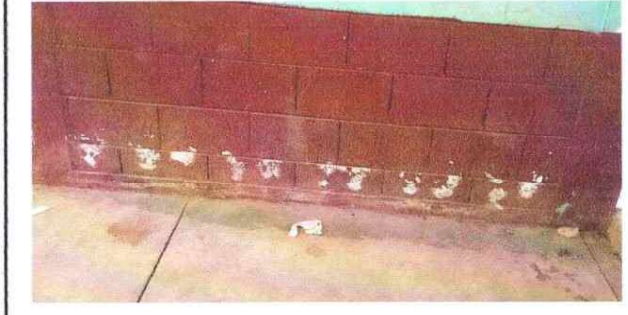
Foto 4: PINTURA DE PAREDES
