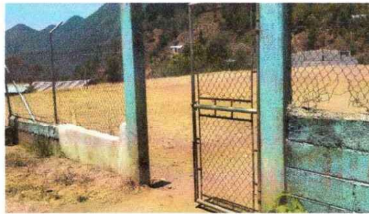
Foto 2: SUSTITUCION DE PORTON
