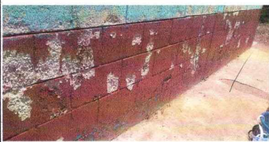
Foto 11: REPARACION DE PAREDES
