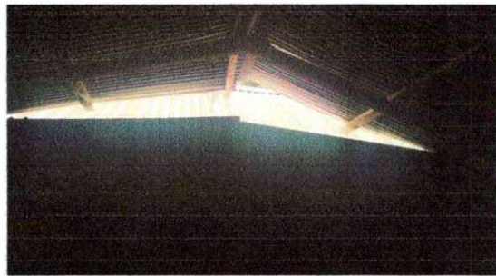
Foto 10: REPARACION Y SUSTITUCION DE TECHO
