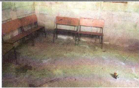
Foto 9: REPARACION DE PISO
