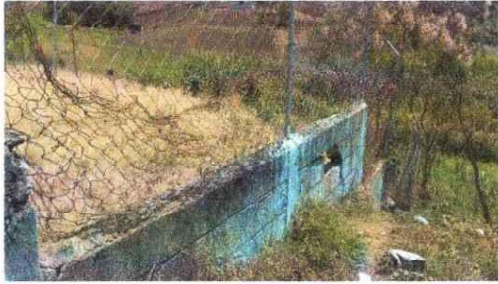
Foto 7: REPARACION DE MURO
