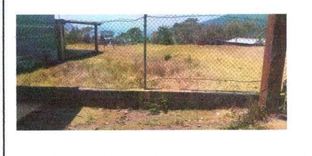
Foto 6: REPARACION DE MURO PERIMETRAL
